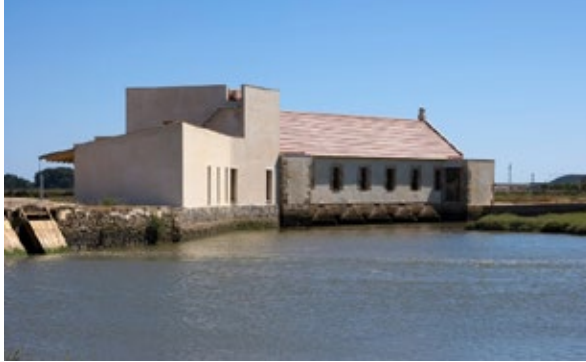
Figura 15: Estado final. Vista general. 2007
